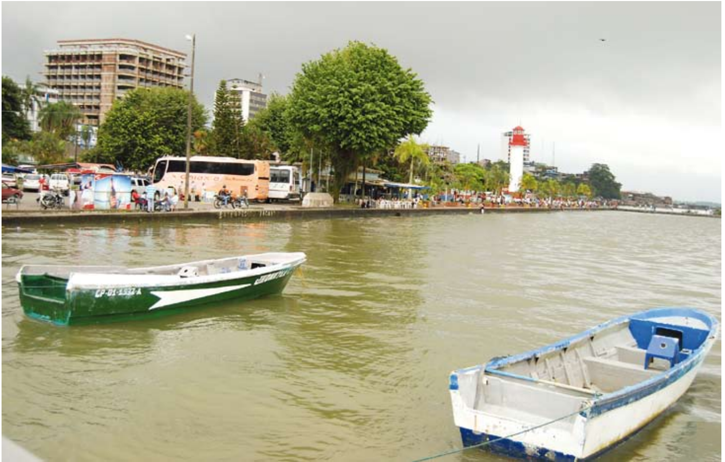
Buenaventura es el puerto más grande de Colombia sobre el Pacífico, pero la falta de infraestructura no lo hace competitivo para el envío y recibo de productos.
